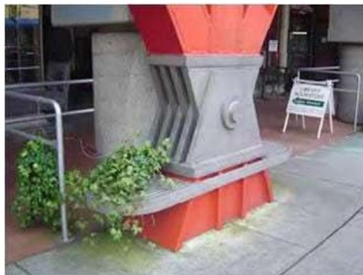
Imagen. 2.20 Detalle de la base del edificio de la foto anterior (los pernos están sometidos a corte)
