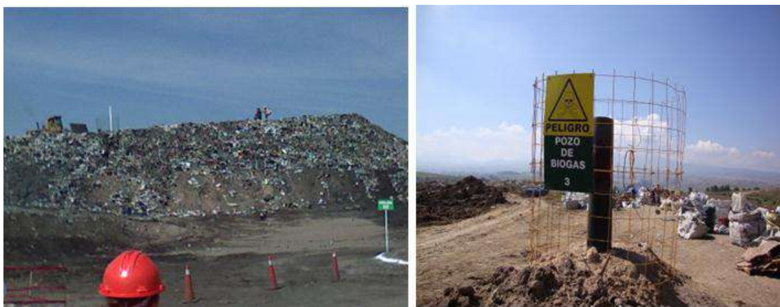
Figura 1. 11 Relleno sanitario húmedo de Zinacantepec, Edo. México, 2012.
