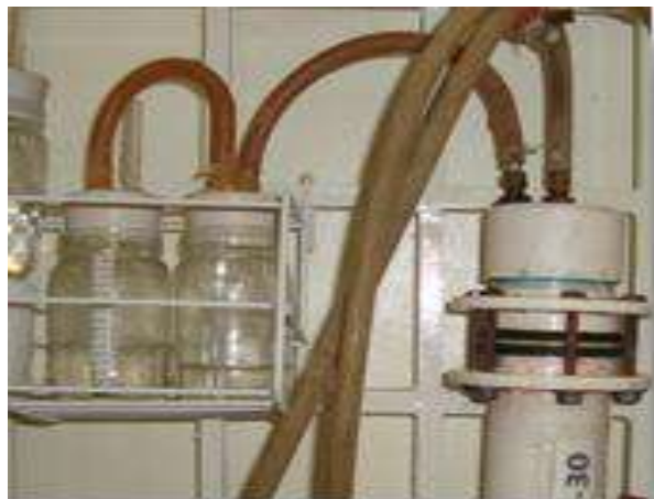
Figura 2. 3 Sistema de biogás.
