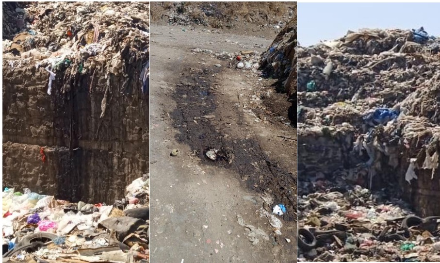
Figura 3.53 Puntos de escurrimiento de lixiviados en la ETY
