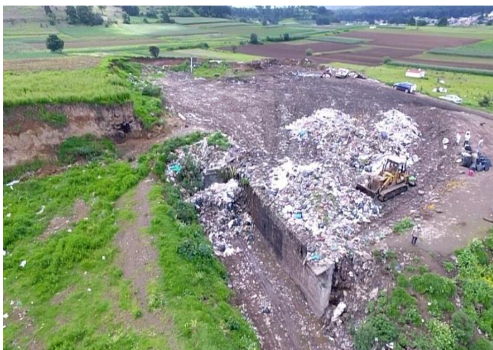
Figura 3.47 Vista aérea de la ETY de Tianguistenco, EdoMéx, septiembre 2019
