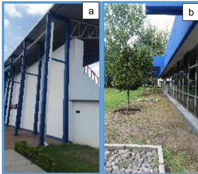
Figura 3.14 Alimentación al subsuelo: (a) Techo de las gradas de las canchas de futbol; (b) Sistema en cascada en la Biblioteca.
