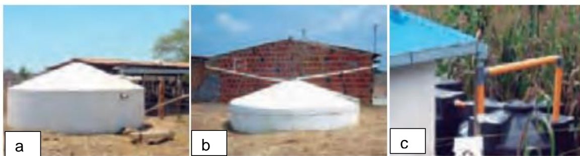
Figura 1.12. Ejemplos de captación de agua de lluvia de techos en diferentes situaciones. a) Cosecha de lluvia de un solo faldón del techo acoplado a cisterna en mampostería, en Brasil. b) Cosecha de lluvia de dos faldones, acoplado a cisterna en mampostería, en Brasil. c) Cosecha de lluvia en techo tipo cuatro faldones, acoplado a tanques de PVC, en El Salvador. Fuente: (FAO, 2013).
