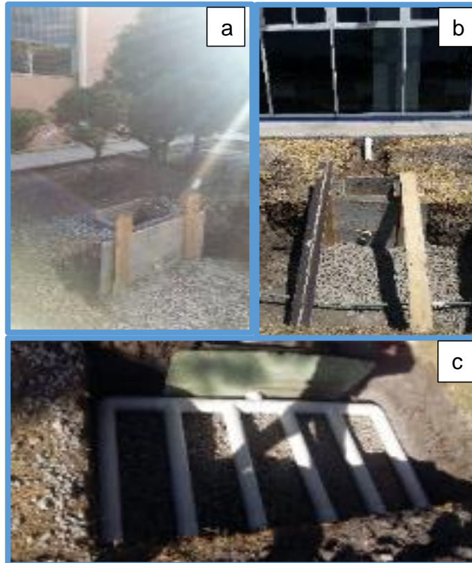
Figura 3.13 Instalación de Manifold: (a) Edificio K; (b) TICS; (c) Hangar.
