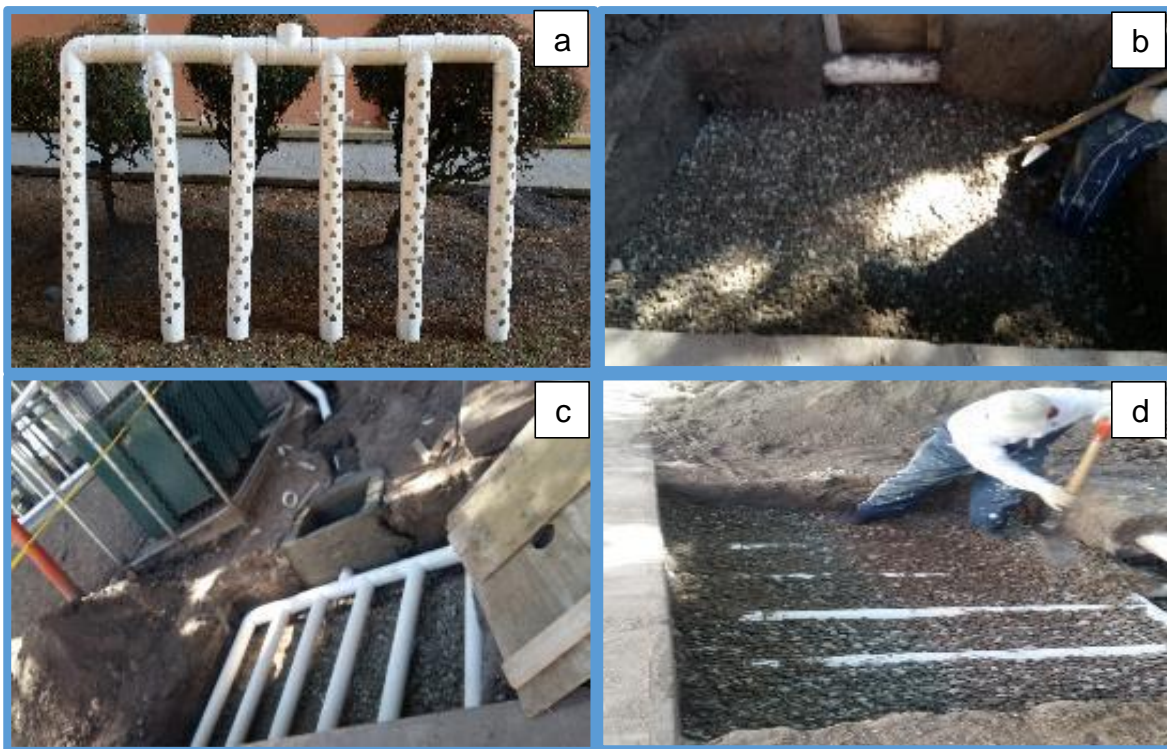
Figura 3.12 (a) Manifold con 31 orificios; (b) Acondicionamiento del lecho de distribución con grava; (c) Manifold conectado en trampa de sólidos; (d) Recubrimiento del lecho de distribución con grava.
