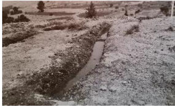
Figura 1.11. Zanja de infiltración. Tecnologías y prácticas para pequeños productores agrarios. Fuente: (Anaya, 2017).
