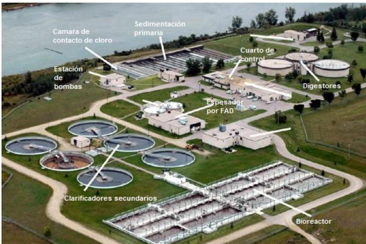
Figura 1. 1 Esquema de tratamiento convencional de aguas residuales (Abdel-Raouf *et al.*, 2012).
