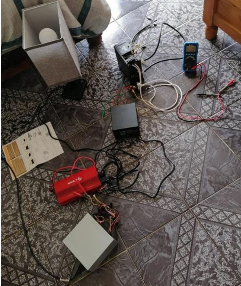
Figura 31 Experimento con fuente, inversor, transformador, variador.
