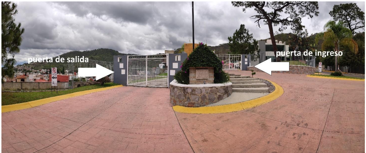
Figura 76 vista frontal del condominio.
