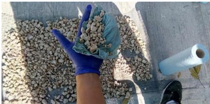
**Figura 3.27 Secado manual del agregado grueso para obtener un estado superficialmente seco**
