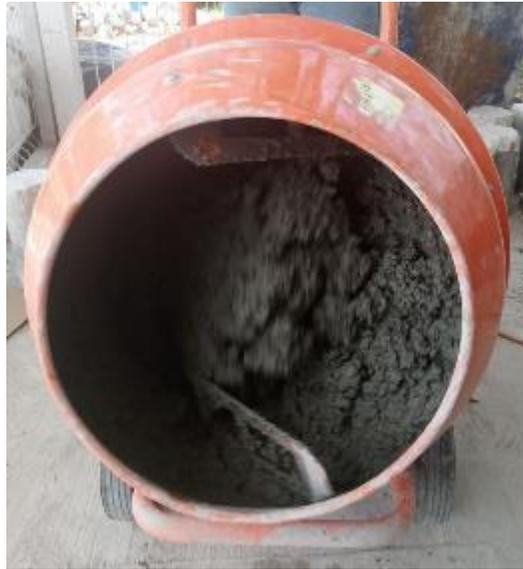
**Figura 3.31 Mezcla de concreto fresco en revolvedora**
