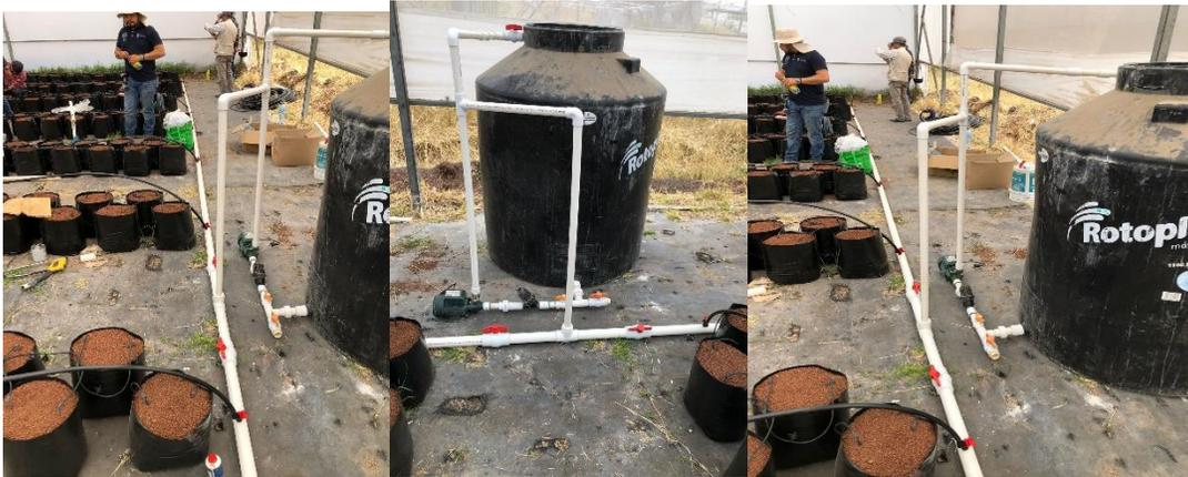
IMAGEN 6 Se observa como quedó instalado el sistema de riego.
