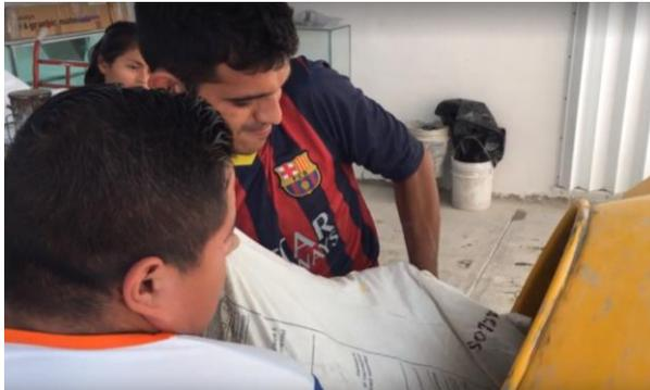
a) Vaciado de agregados en revolvedora
