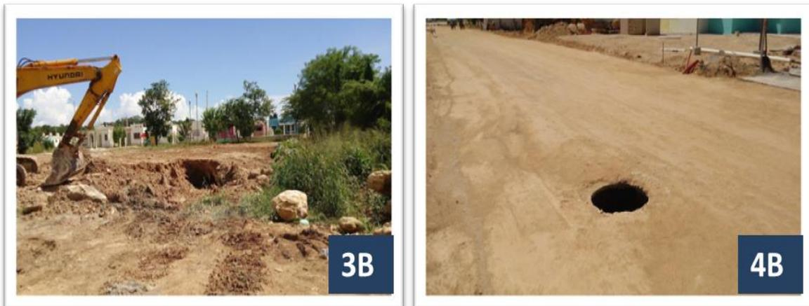
En la figura 3B se observó que utilizan maquinaria pesada sin conos de precaución para delimitar el área de movimiento, asimismo en la figura 4B se aprecia que existen hoyos destapados en el área del andador que no están señalizados.
