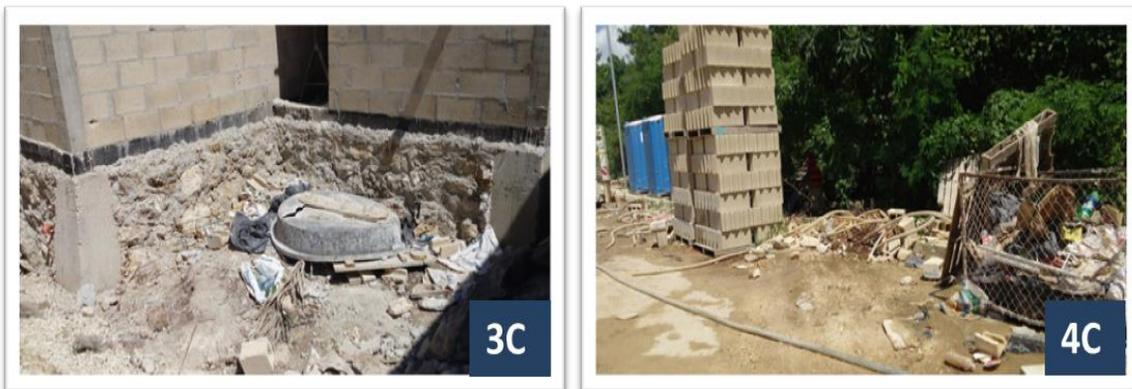
En la figura 3C se observó que el área de trabajo era obstruida por basura y por elementos de colado dañados, asimismo podemos ver en la figura 4C que aunque contaban con depósitos de basura, los trabajadores no le daban el correcto uso por lo que terminaban regando la basura en los andadores y área de acceso.
