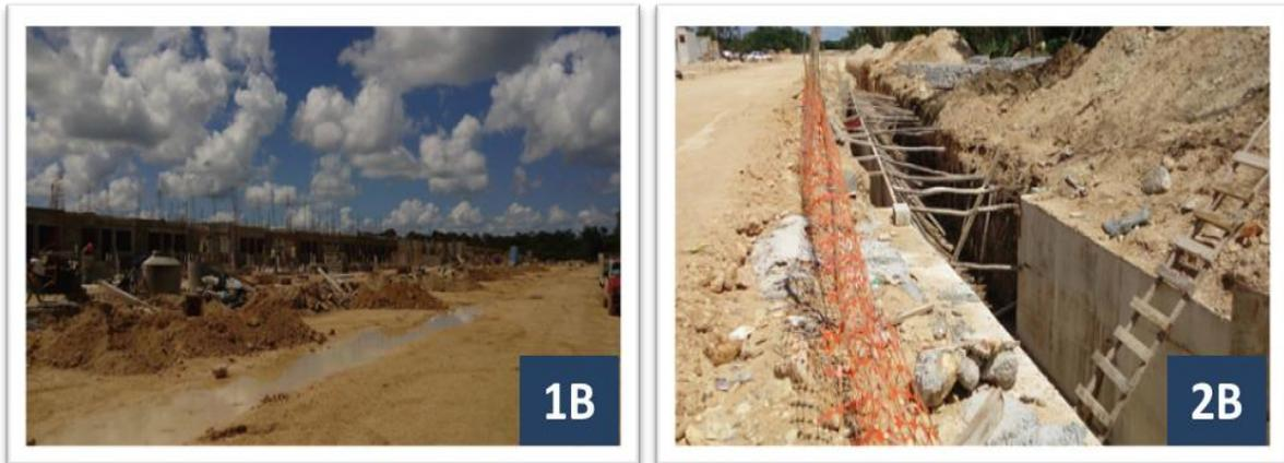
En la obra B se observó que los andadores están desnivelados y contienen desperdicios de excavación debido a la construcción de la cimentación, en la imagen 2B se puede percibir manejan una cinta de seguridad para delimitar la excavación y puntales para evitar el derrumbe del mismo. El tipo de escaleras que suelen utilizar, son elaboradas con palos rústicos de madera e inestables.
