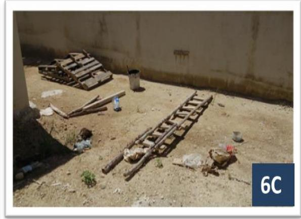
En la figura 5C los accesos están obstruidos en aproximadamente un 20% del área con material de construcción, desperdicio y andamios, por otra parte en la figura 6C se puede apreciar que los trabajadores utilizaban escaleras elaboradas de palo rustico de madera, mismas que se encontraban empataadas con alambrcn siendo inestables para los trabajadores.
