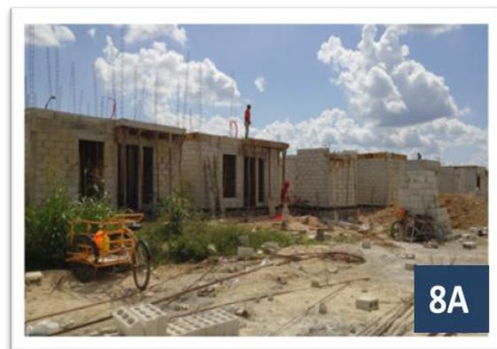
En la figura 7A se muestra que el material de construcción está dispersado por la obra, asimismo se puede observar que no cuentan con un almacén para resguardo de su material, por otra parte en la imagen 8A se muestra nuevamente la obstrucción de andadores y área de trabajo con equipos de transporte de los trabajadores, lo anterior debido a que no hay un área de estacionamiento para los mismos.
