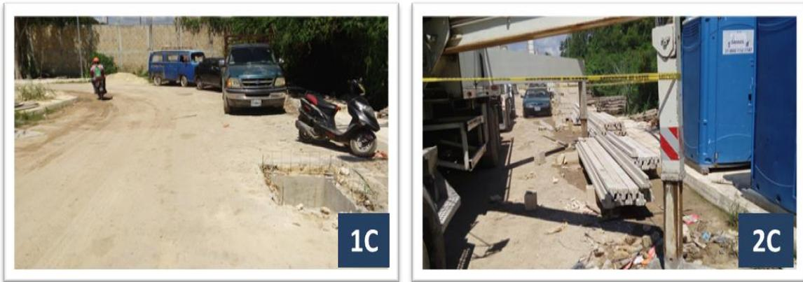
En la obra C se observó que no contaba con estacionamiento, por lo que los elementos de transporte de los trabajadores obstruían el acceso principal, igualmente en la figura 2C se observa que el acceso a los baños se encuentra obstruido por material de construcción y desperdicio del mismo. Cabe mencionar que en la figura 1C se puede observar no se encuentran señalizados los hoyos en el área de acceso.
