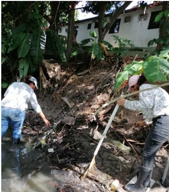
Figura 11 Limpieza del estero de Tenechaco.
