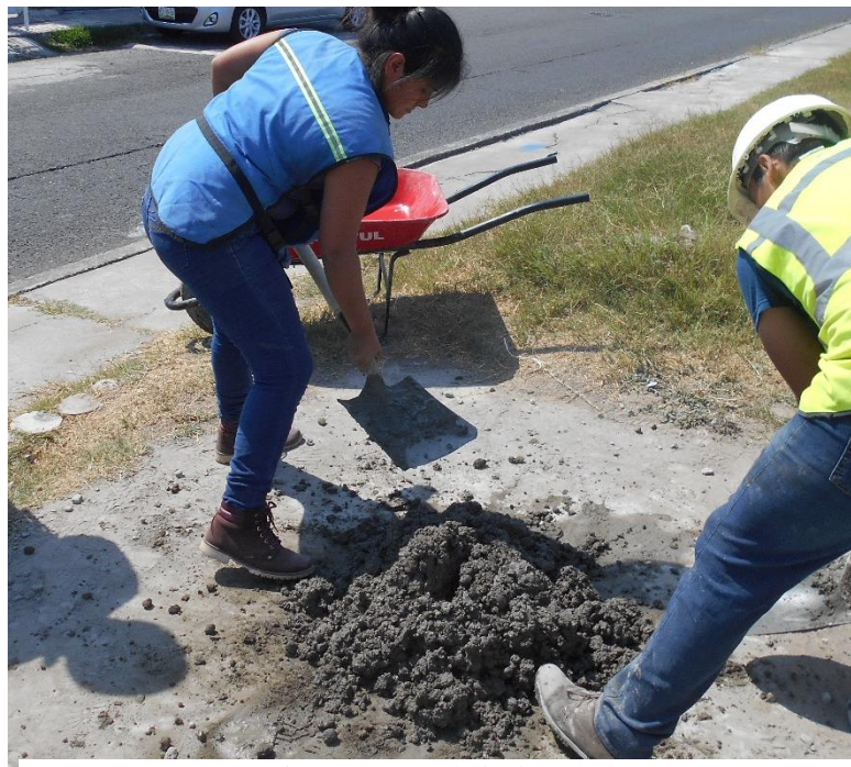
Figura 3. 62 Colado de mezcla
