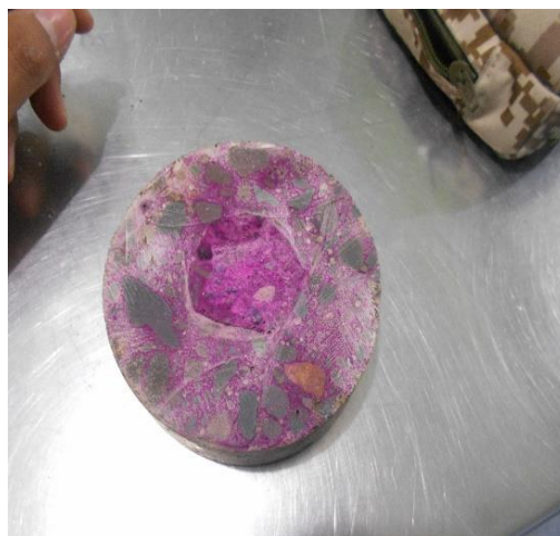
Figura 2. 5 Carbonatación en el concreto observada con un indicador colorimétrico
