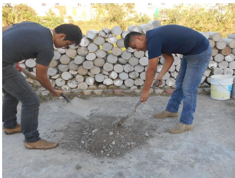
Figura 3. 61 Revoltura de mezcla
