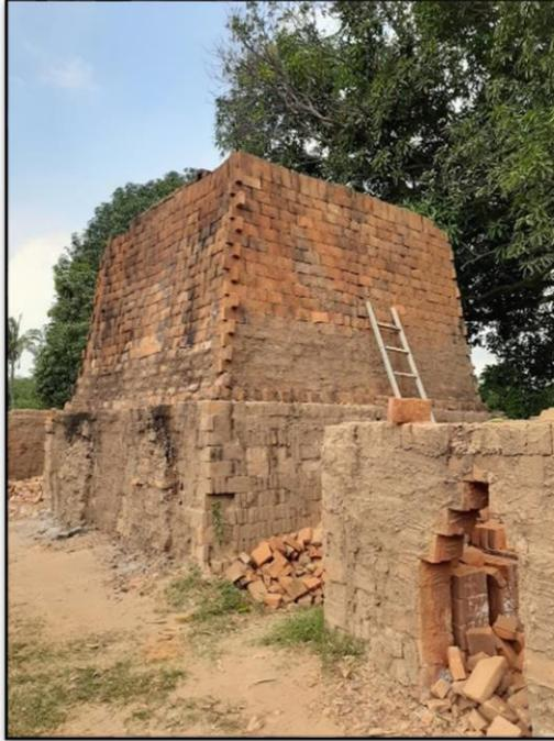
Figura 4.14 Horno para cocción de tabiques con sulfato de calcio.
