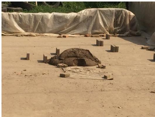
Figura III.9 Reposo de la mezcla de barro.
