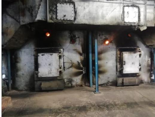
Figura II.17 Calderas de combustión de bagazo de caña de azúcar.
