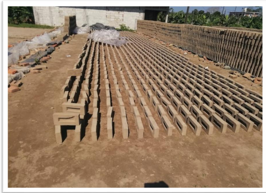
Figura 3. 6 Estibado de tabiques (Autor propio)
