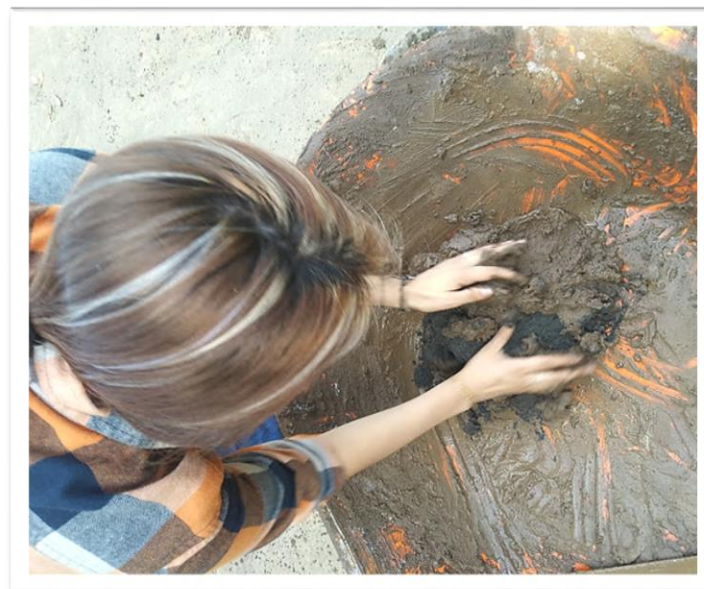
Figura 5. 7 Homogenización del adiconante con la masa tradicional (Autor propio)
