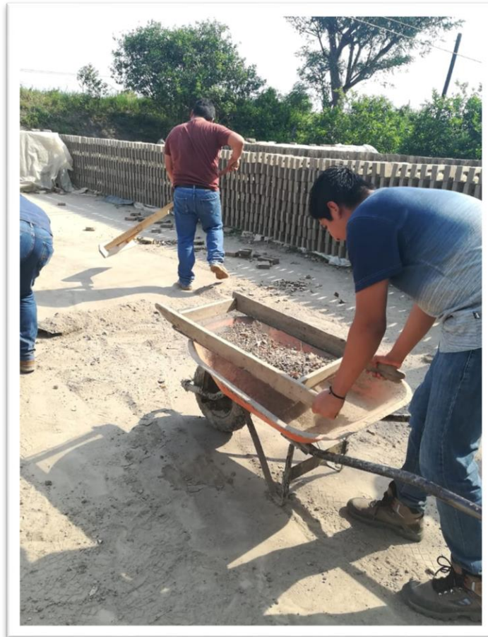
Figura 3. 11 Cernido de arena a utilizar en la mezcla para los tabiques (Autor propio)
