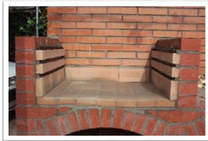
Figura 2. 14 Tabique refractario (Albañiles, 2014)
