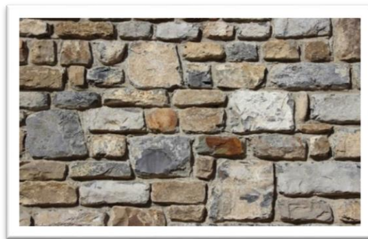
Figura 2. 1 Mampostería ordinaria (Cibao, 2018)
