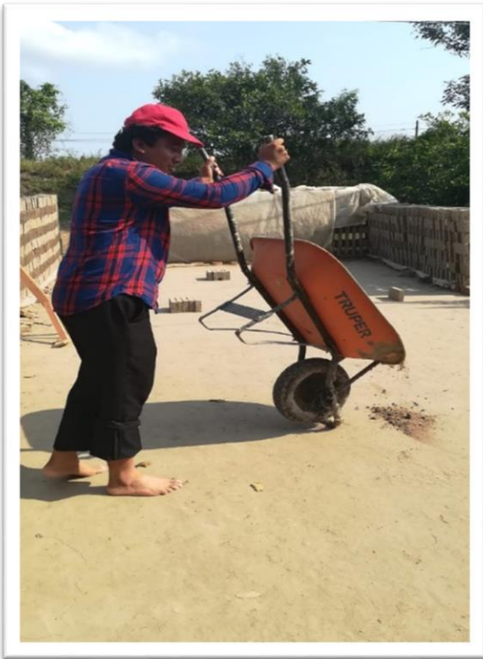
Figura 3. 13 Esparcido de arena cernida donde se realizó la mezcla (Autor propio)
