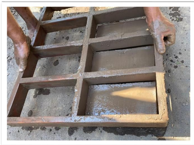
Figura 5. 9 Desmolde de tabiques modificados (Autor propio)
