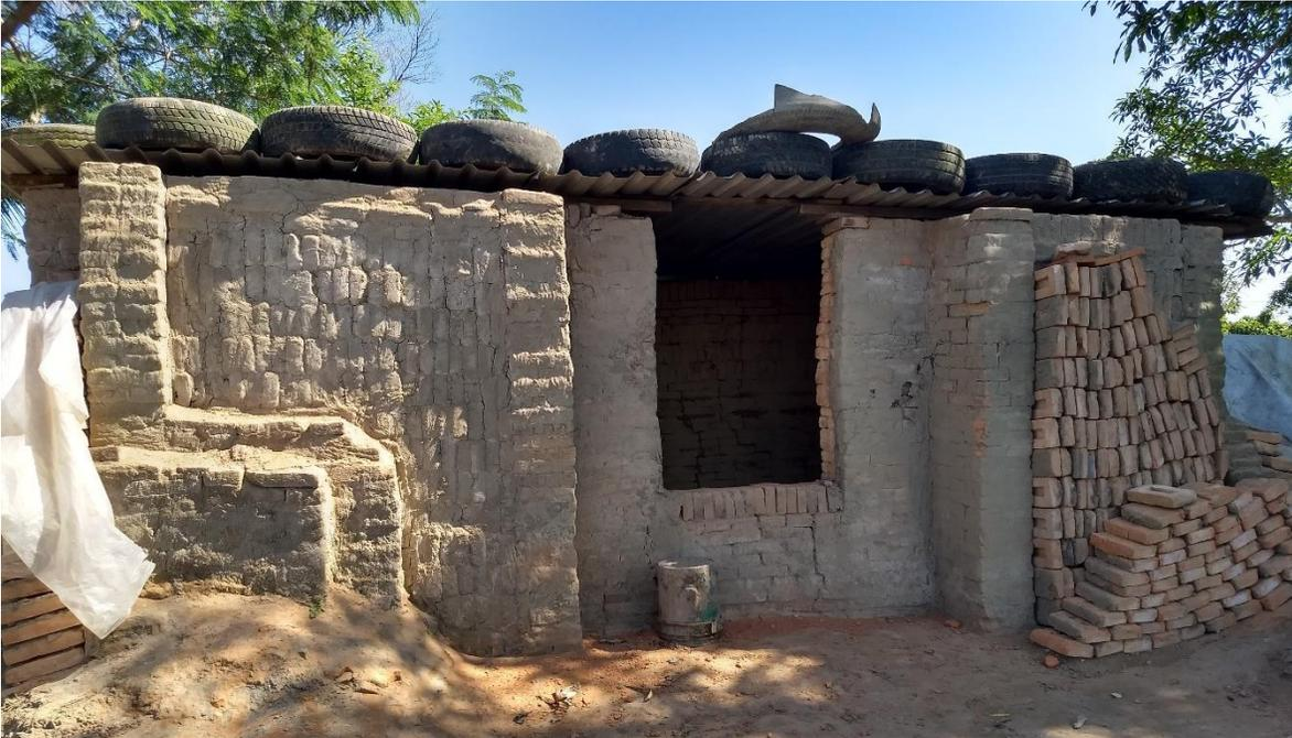
*Fig. 1. 19 Horno elaborado de tabique y sellado con arcilla de la zona.*
