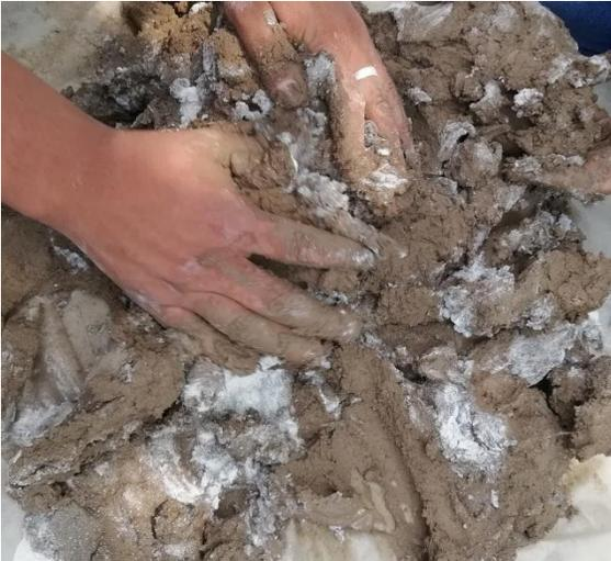
*Fig. 3. 16 Adición de cemento a la mezcla.*
