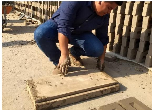
*Fig. 2. 16 Desprendimiento de la gavera (Es necesario aplicar un par de golpes)*
