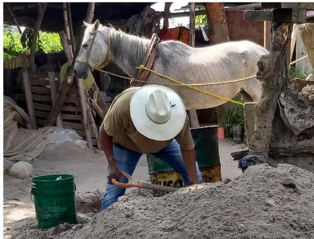
*Fig. 2. 9 Homogenización de los materiales antes de ser vertidos al molino.*
