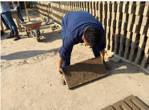
*Fig. 2. 15 Gavera con material previamente moldeado.*
