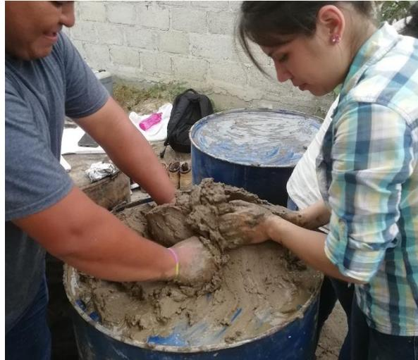
*Fig. 3. 15 Amasado de la mezcla para homogenizar el cemento.*
