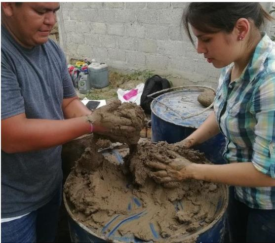
*Fig. 3. 14 Mezcla homogenizada con cemento.*
