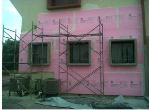
Paso2.- Colocar con placa mediante cemento y amachimbrado a la pared.
