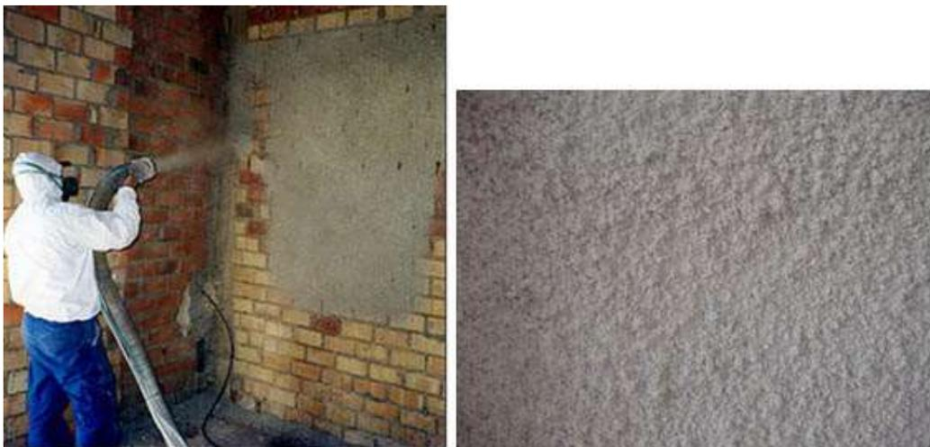
Ilustración 2.6.- Lana de roca proyectada (mortero tecwool)
