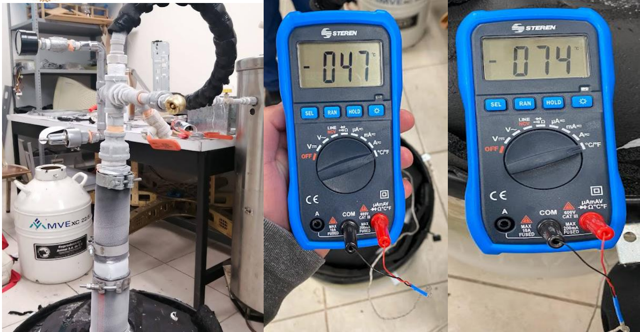
Figura 3.32. Lecturas de temperatura realizadas durante las pruebas de funcionamiento del sistema
