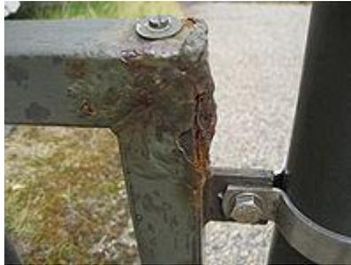
**Ilustración 17 Corrosión por deterioro del revestimiento.**
