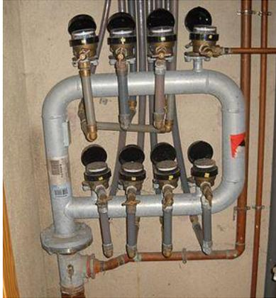
**Ilustración 19** Este soporte de batería de contadores de agua, ha tenido que sustituir al original a los 4 años de uso, por estar conectado a una tubería de cobre del edificio (0,85 V de diferencia de potencial, ver el punto de corrosión abajo a la izquierda),
