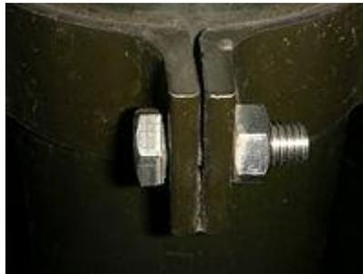
**Ilustración 16** Corrosión de tornillo en la unión con otro metal, expuestos ambos a la humedad ambiental.
