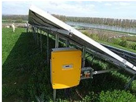
**Ilustración 23** Un inversor solar instalado en una planta de conexión a red en Speyer, Alemania.
