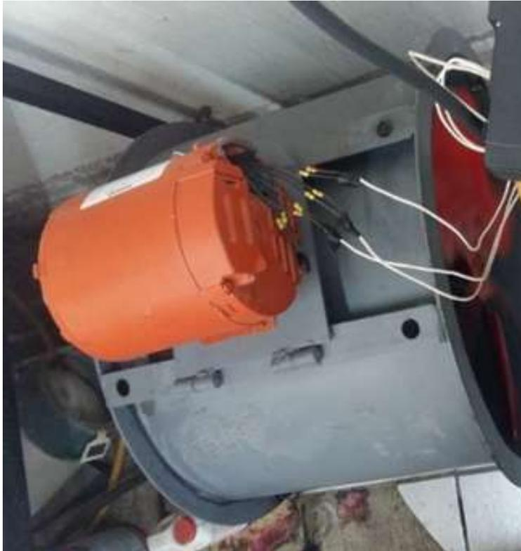
**Figura 4.19.** Conexión Variador de velocidad – Ventilador Tubular.
