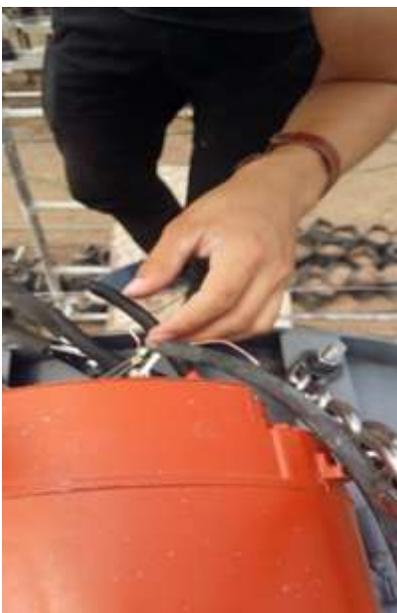
**Figura. 4.** Conexión trifásica de motor a variador.
