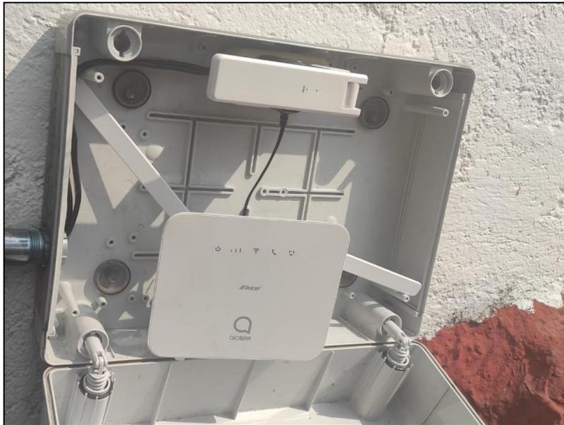
Figura 31 interior del gabinete de monitoreo, DTU lite.
