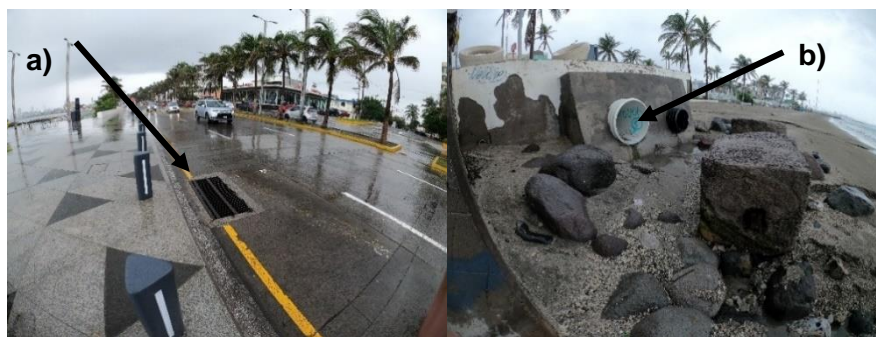
Figura 18. Tránsito vehicular en el Boulevard Manuel Ávila Camacho en la época de lluvias, se puede observar el alcantarillado colector de agua pluvial en la fotografía a) y su desagüe descargando el agua a la playa en la fotografía b).
