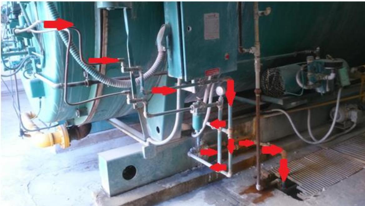
Fotografía 2.15.5.1. Señalamiento del flujo del retroceso.
