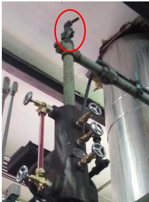
Fotografía 2.3. Válvula de prueba.
