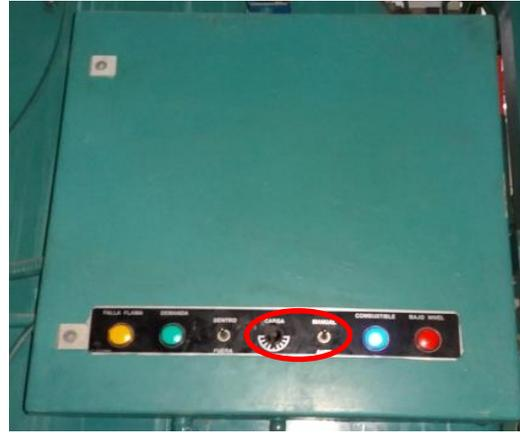
Foto 2.9. Motor modulador. Foto 2.9.1.1. Interruptor y potenciómetro de carga.
