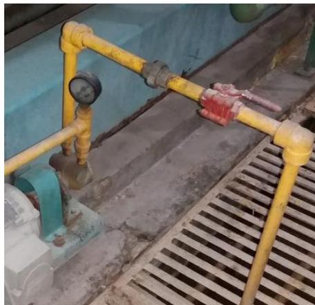
Fotografía 2.10.3.3. Válvulas de paso de Diésel.
