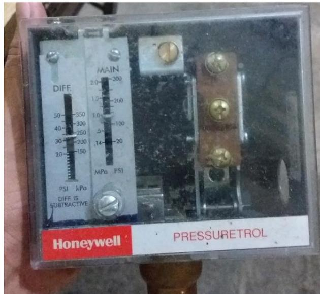
Fotografía 2.2.1. Regulador del presostato.
