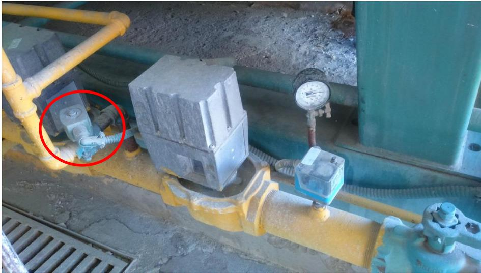
Fotografía 2.14.1.9. Válvula de ventilación.
