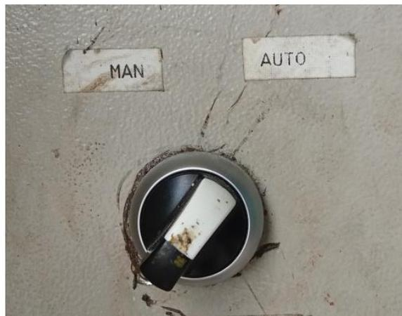
Fotografía 2.8.1.3. Activador manual-automático de la bomba.
