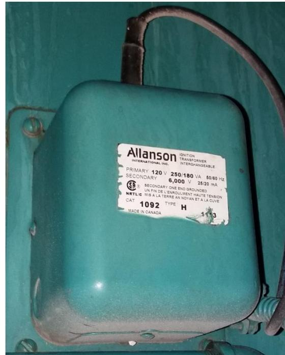
Fotografía 2.11. Transformador de ignición.
