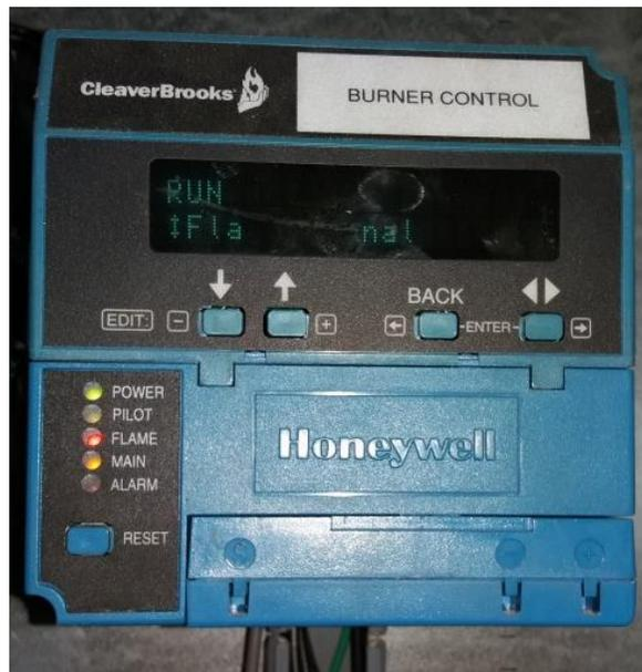
Fotografía 2.10.1. Control de quemador (microprocesador).
