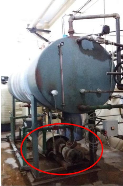
Fotografía 2.8.1.1. Tanque de condensados.
