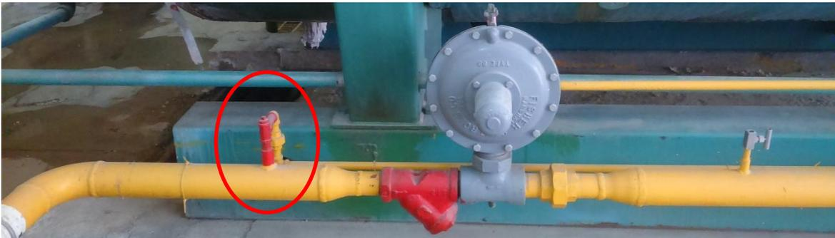
Fotografía 2.14.1.12. Toma de conexión para fugas.
