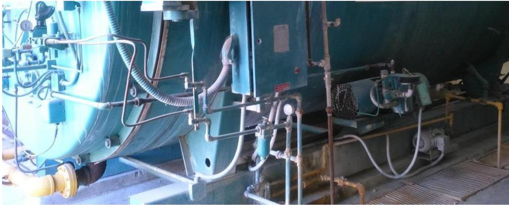
Fotografía 2.15.5. Tubería de retroceso del combustible.
