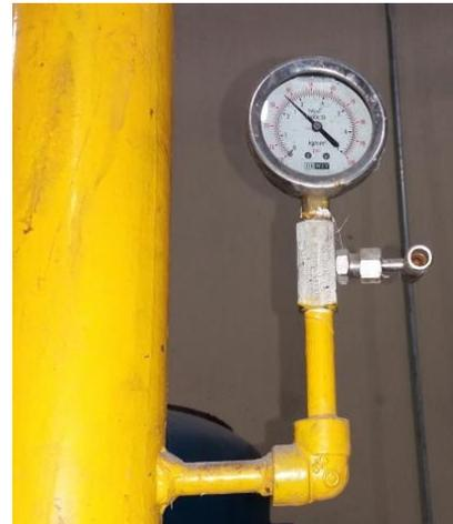
Foto 2.10.3.2. Manómetro del Gas.
