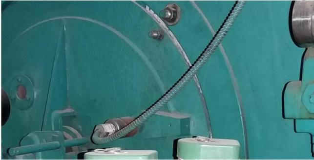
Fotografía 2.13. Sensor óptico detector de flama.
