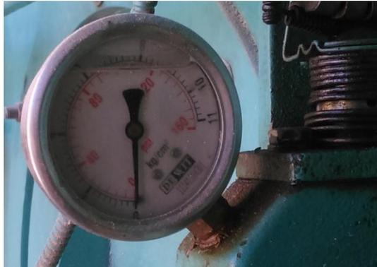
Fotografía 2.15.8. Manómetro de válvula reguladora.
