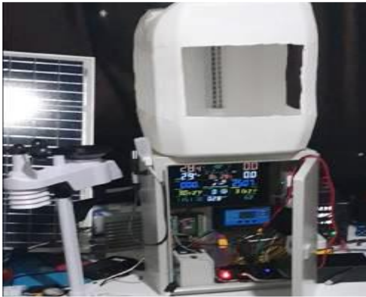
Anexo 3 Pruebas de estación de control.
