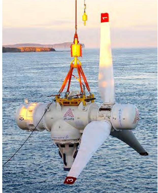
**Figura 3.** Turbina SIMEC Atlantis de MeyGen instalada en Pentland Firth (Escocia) [11].
