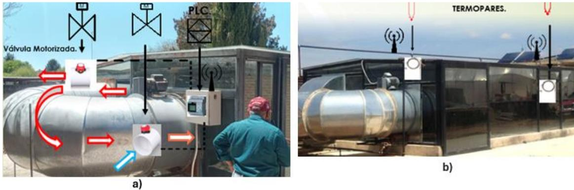
*Nota.* Elaboración Propia, Ubicación de PLC, Válvulas Motorizadas en Ductos de Ventilación y Gabinete de Control a) y Equipos de Medición en Cámaras de Deshidratado b).
