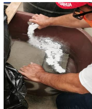
Figura.103. Adición de cal en el agua de curado.
