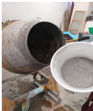
Figura.63. Incorporación de cemento a la olla.
