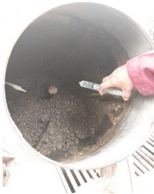
Figura.60. Incorporación de súper plastificante a la mezcla.
