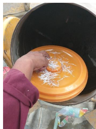
Figura.73. Colocación de fibras estructurales.
