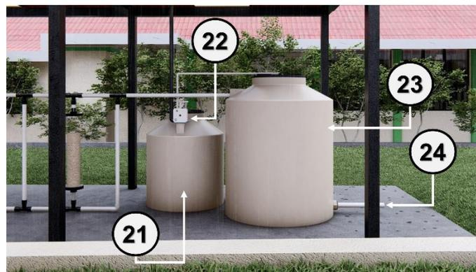
El paso final en el tratamiento es el *tanque de cloración* (23), en él, a través de una cloración compuesta, el *tanque de cloro* (21) suministra y desinfecta el agua para su posterior uso y distribución (24). Este se dosifica a través de un dispensador automático (22).
