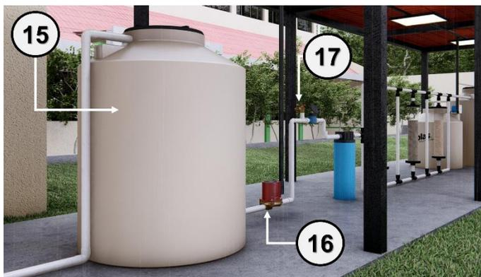
El *panel de control* (13) tiene la función de controlar las *bombas* (12)(16) y las luces del sistema. El *medidor de flujo* (14)(17) se encarga de medir el caudal entrante al *tanque de pretratamiento* (15).
