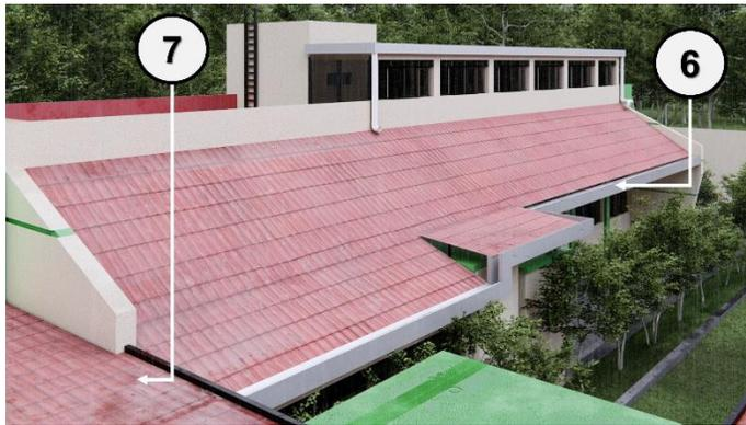
Las *segundas canaletas* (6) tienen como función principal el captar el agua proveniente de la primera y segunda zona de captación para llevarlas aguas abajo. Por otro lado, la *tercera zona de captación* (7) se encarga de captar el agua que cae en
