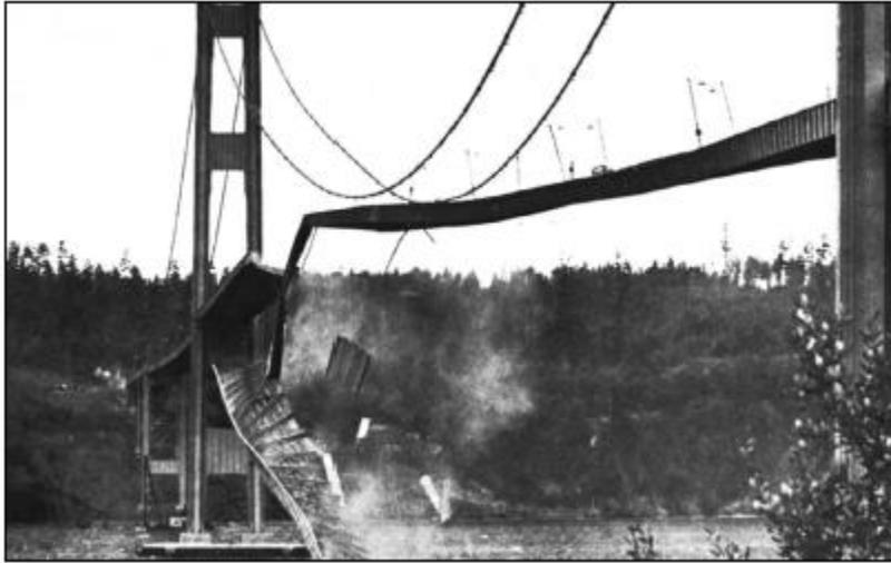
Figura 11 El puente Tacoma destruido debido al fenómeno de la resonancia. [43]
