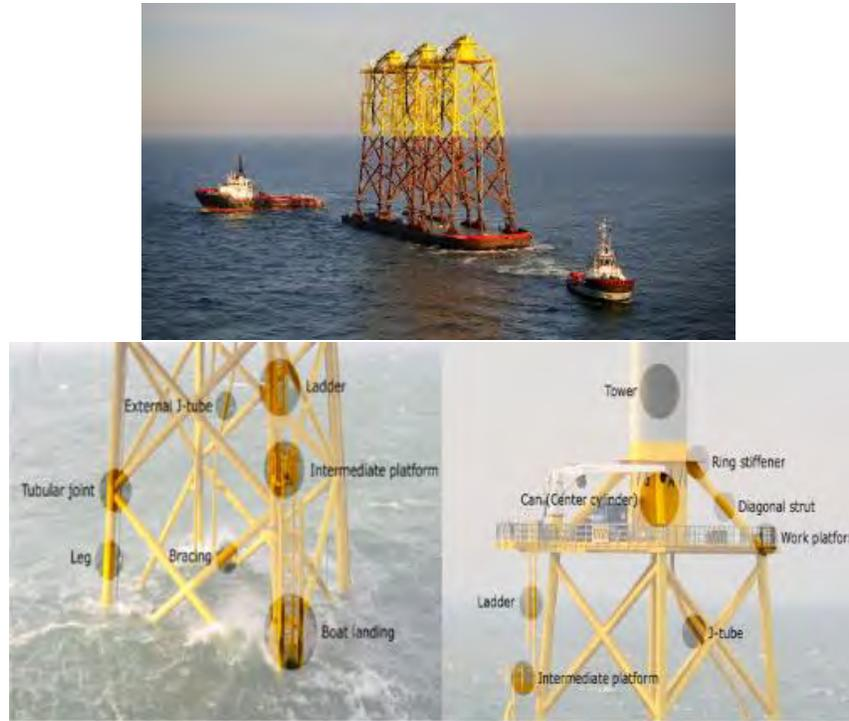
Figura 4 Estructura tipo Jacket.[22]
