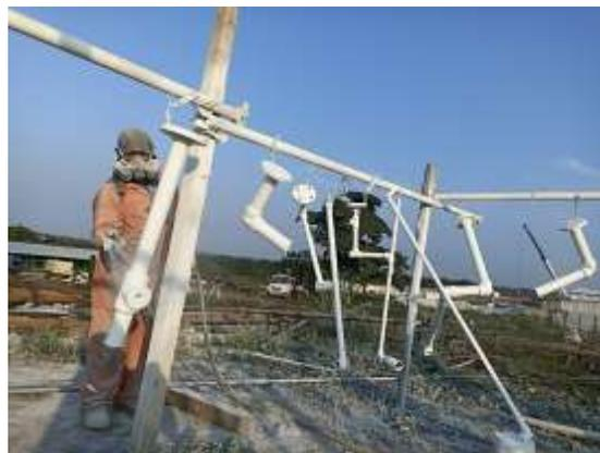
**Ilustración 33 Medidas de seguridad para pintor industrial**
