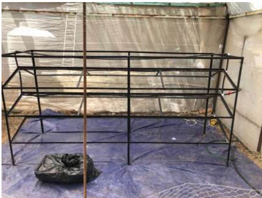
Figura 3.4 - Preparación del área.
