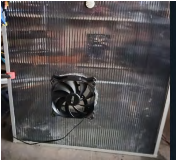
Figura 3.23: Colocación de los ventiladores en los costados
