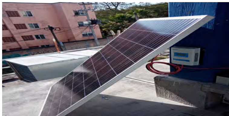
Figura 4.14: Instalación del segundo panel solar.
