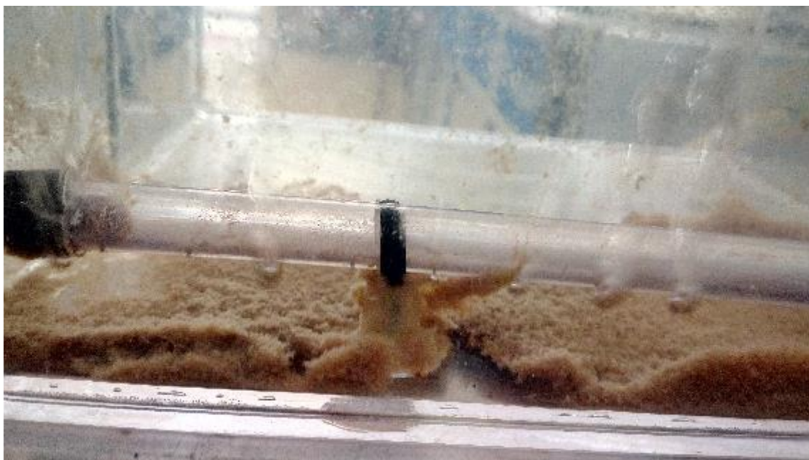
Figura D. Agua residual clarificada y cama de lodos.
