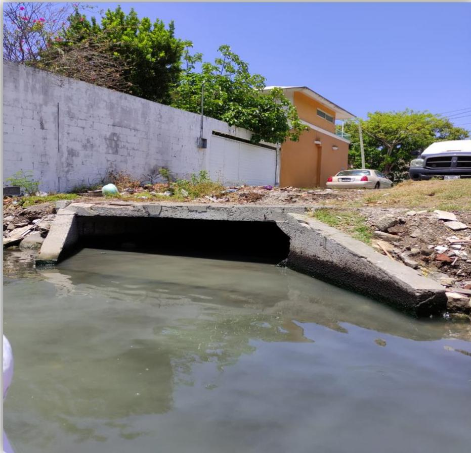
**Figura 20.** Descargas pluviales.
