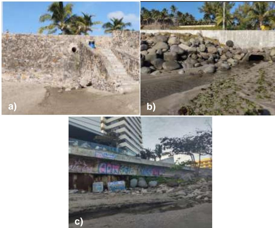
Figura 15. Principales tipos de desagües en zona de playas Veracruz-Boca del Río. Ejemplos de a) Desagüe pluvial, b) Cañería y c) Fuente puntual de origen desconocido.
