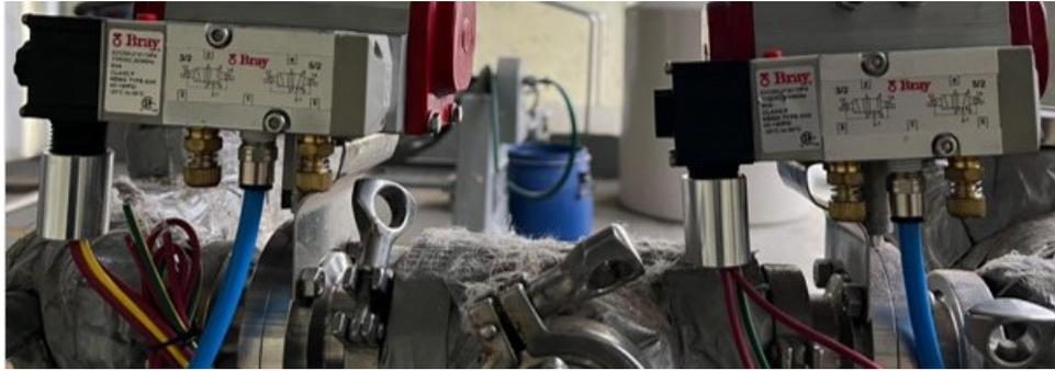
**Figura 5.11: Válvula Solenoide NAMUR**
