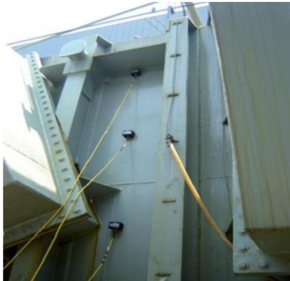
**Figura 2.2.** Detección de DP acústica en un Transformador
